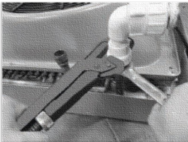
Рис.4. Подключение теплообменника тепловентилятора
